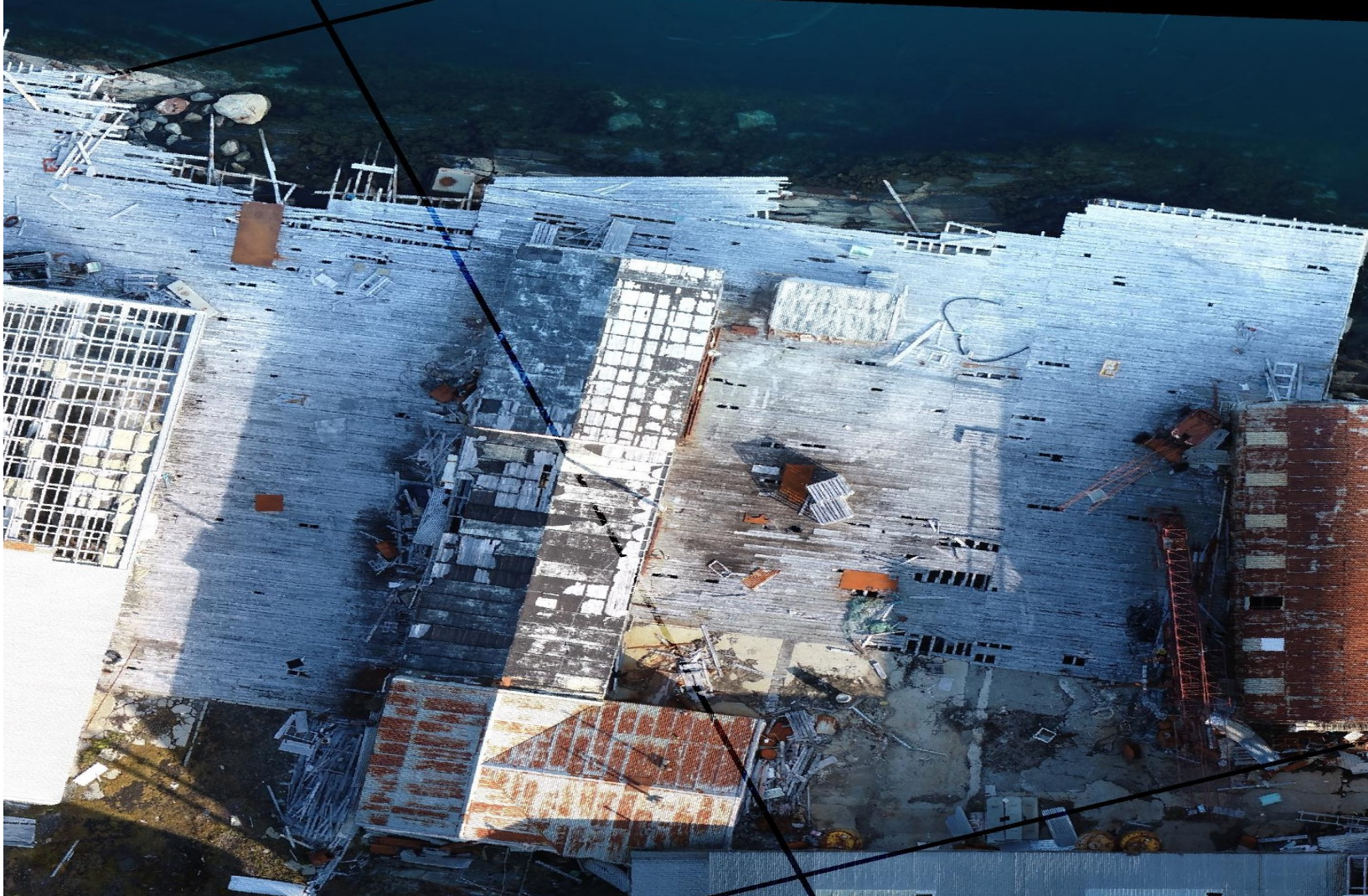
Figur 0.22 Bryggen fremstår med adskillige huller, i en meget nedbrudt flade. Se også figur 0.17 og 0.18. (Dronefoto, 2019)
