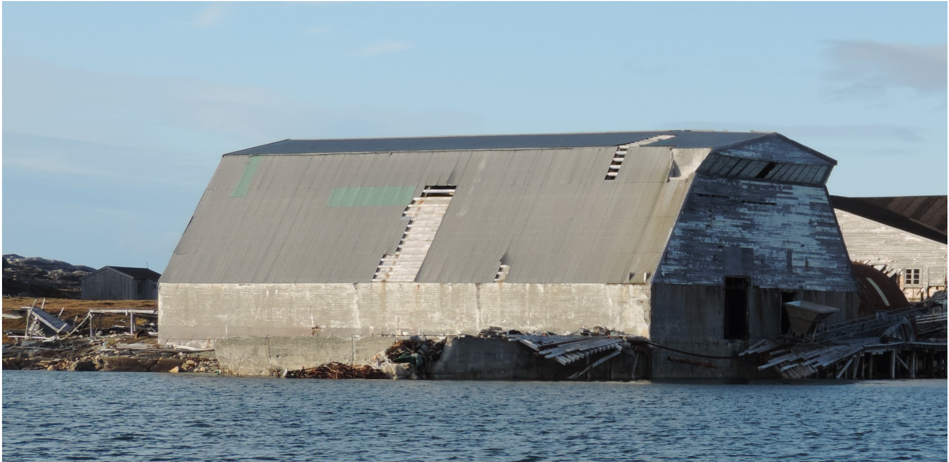
Figur 0.16 Saltsilo B-20. Tagfladen har huller, der åbner konstruktionen for elementerne. Disse må forventes at øge i areal.
