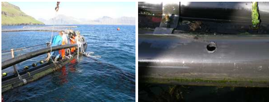
Mynd 4.1: Til vinstu: Sökkringurinn fleyt aðrenn hol var sett á hann, og verður hér sleipaður út til alibrúki. Til hægri: Sökkringurinn verður lyftur uppum aliringin.
