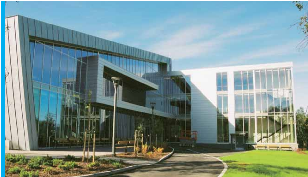
Breivang videregående skole, Tromsø. Foto: Stein Torgeir Aukland, Breivang videregående skole
