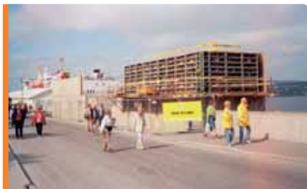
Terminalen under oppføring. Foto: Kjell Olav Olaussen
