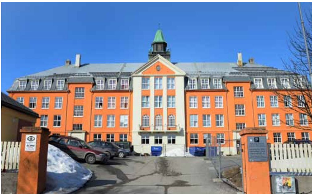
Kongsbakken videregående skole i Tromsø renoveres med midler fra tiltakspakken. Foto: Stian Saur
