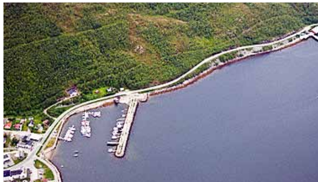
Skråbildefotografering av strandsonen. Foto: Prosjektfoto
