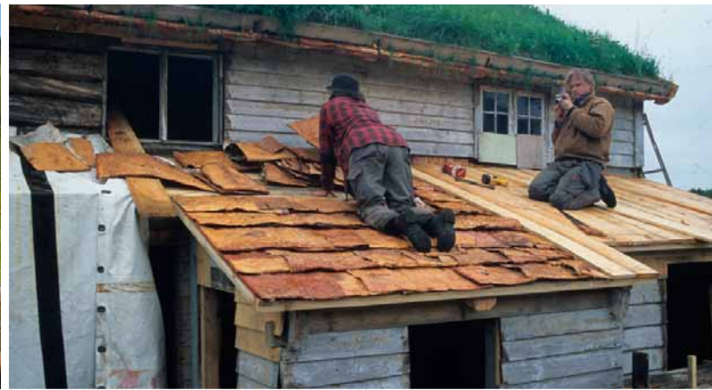
▲ Takteking med never og torv er et handverk som bare noen få kan. Dokumentasjon av arbeidet er viktig. Foto: John Hansen
