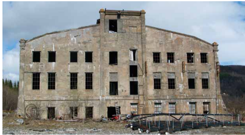
▲ Salangsverket i Salangen ble bygd opp tidlig på 1900-tallet. Det ble tatt ut jernmalm i gruvene på Storhaugen, malmen ble fraktet med taubane ned til anlegget på Salangsverket hvor det ble produsert jernbriketter som ble eksportert til Sentral-Europa. På det meste jobbet 800 mann på anlegget. Anleggsperioden varte fra 1907-1910 og anlegget var i drift fra 1910 til 1912. Foto Marit Chruickshank
