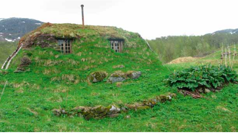
▲ Gammen er en boligkonstruksjon som trolig har vært brukt fra eldre steinalder og helt fram til vår tid. Her illustrert ved en gamle fra Vilgesvarre i Skånland. Foto: Marit Chruickshank
