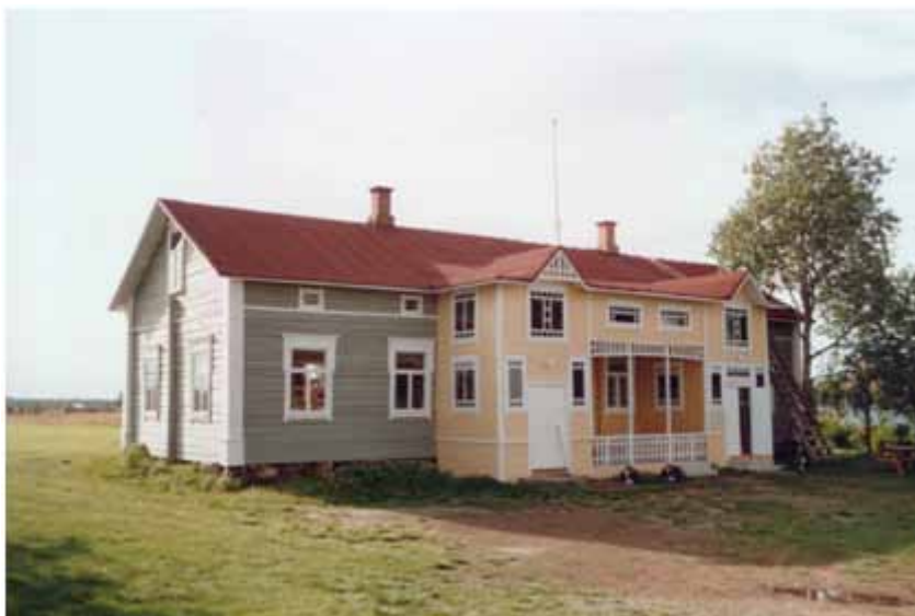
Bilder 8 og 9. Marttiini hus i Kairala under reparasjon og etter reparasjon. Foto: Kari Tallavaara.
