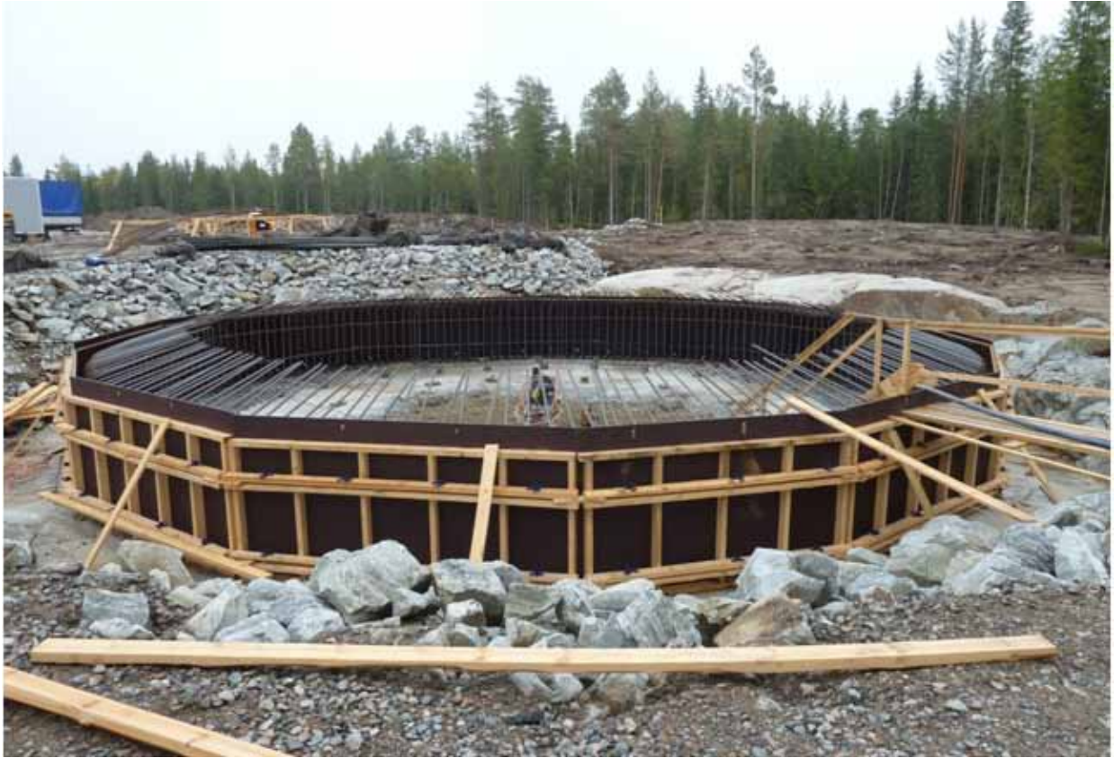
Bilde 3. Et vindkraftverk er en meget stor konstruksjon. Til grunnvullen går det for eksempel omtrent 600 m 3 stålbetong. Også monteringsplassen og annen infrastruktur som må bygges i forbindelse med kraftverkene forandrer naturen i området betydelig, spesielt på sårbare bakketopper. Foto: Timo Jokelainen
