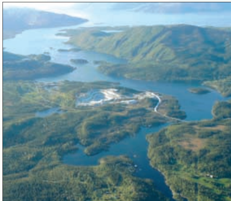
Kalkbruddet i Brønnøy.
