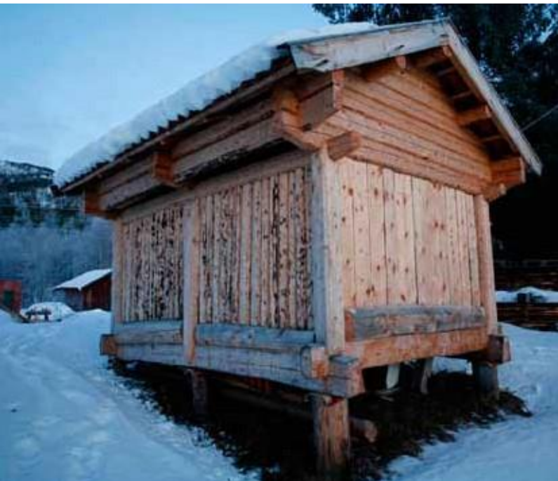
Jagi 1713 skielttaráitti málle mielde ráhkaduvvon ođđa áiti Sjåvikii Málavuntii. Ođđa áitti ráhkadedje Roald Renmælmo, Trond Oalann ja Siv Holmin. Govvideaddji: Roald Renmælmo
