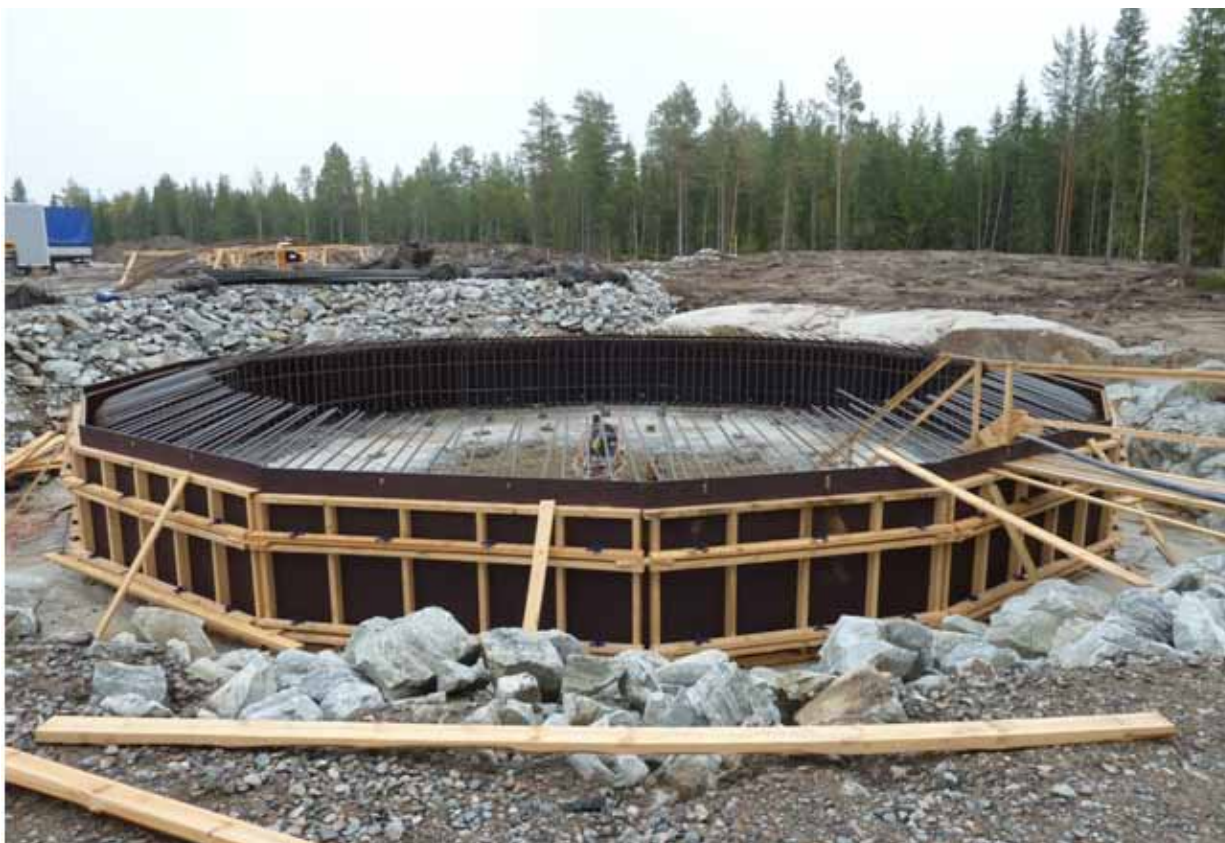
Govva 3: Bieggafápmorusttet lea hirbmat ráhkadus. Ovdamearkka dihte dan vuođu bidjamii gollá sullii 600 m 3 stállebetonga. Maiddái stellensadji ja eará infrastruktuura, mii ráhkaduvvo fápmorusttegiid várás, rievdata saska guovllu luonddubirrasa áinnas rašis alášguovlluin. Govva: Timo Jokelainen
