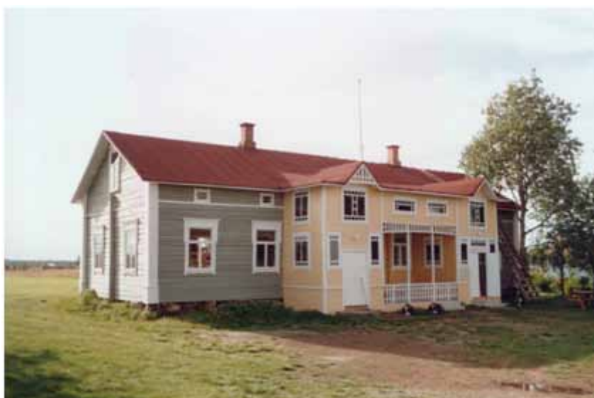
Bilder 8 och 9. Marttiinis hus renoveringens tiden och efteråt. Bilder: Kari Tallavaara.
