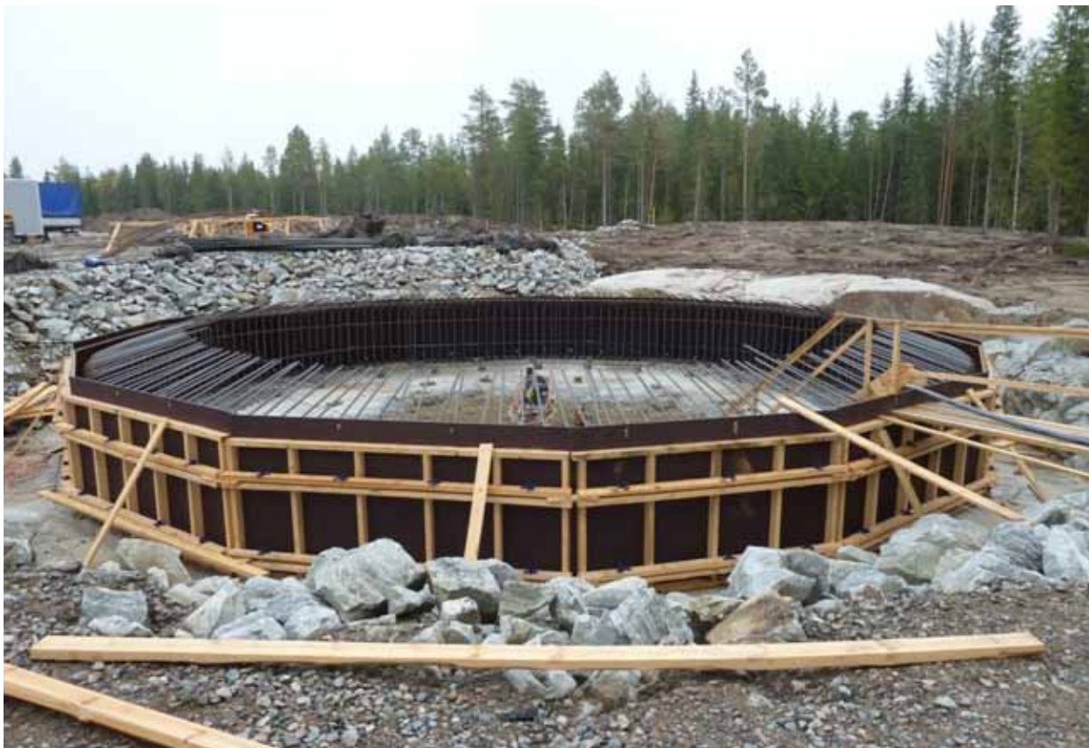
Bild 3: Ett vindkraftverk är en väldigt stor konstruktion. Till exempel till dess grund behövs ca 600 m 3 armerad betong. Även byggnadsytan och övrig infrastruktur som behövs vid kraftverksbygge kommer att förändra naturmiljön i området, särskilt i känsliga höglänta områden. Bild: Timo Jokelainen.
